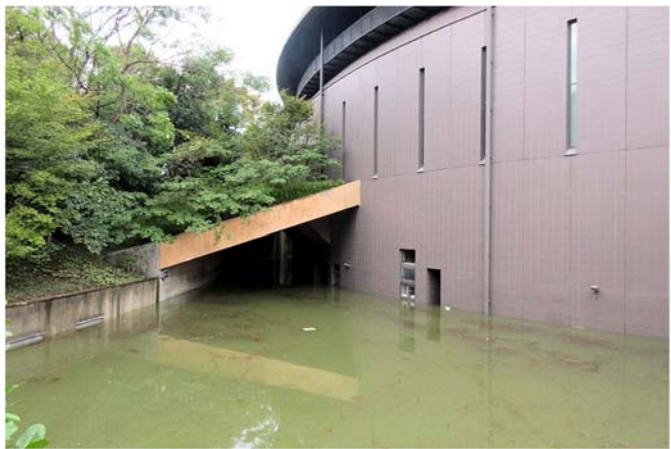
水没した川崎市市民ミュージアム
